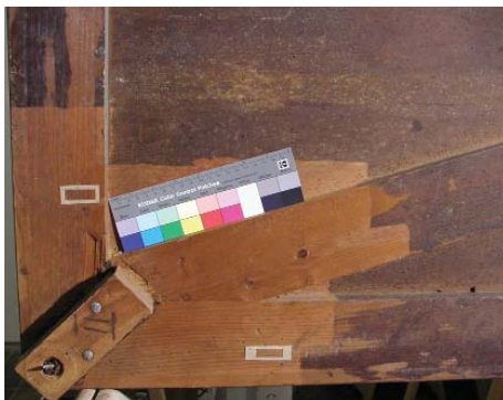
Abb. 2: Ansicht nach Laserabtrag der Biozidbeläge
