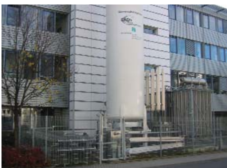
Abb. 1: Stickstoffversorgung mit Förder-, Misch- und Regelungssystem
